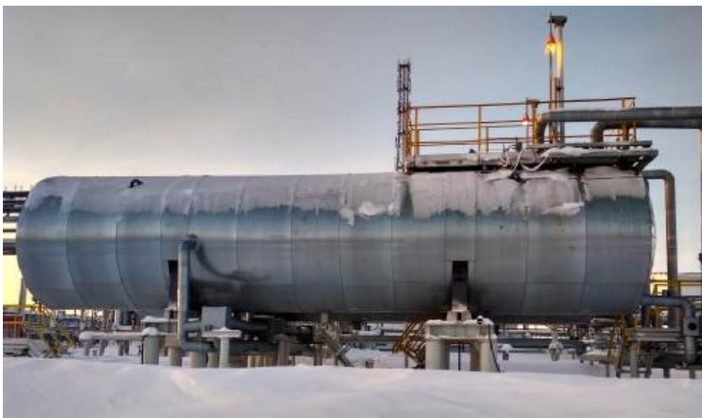
Рисунок 1 – Общий вид резервуара стального горизонтального цилиндрического РГС-100
