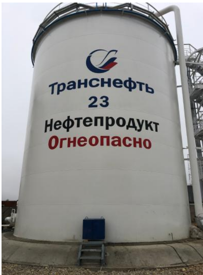
Рисунок 1 – Общий вид резервуара стального вертикального цилиндрического РВС-1000
