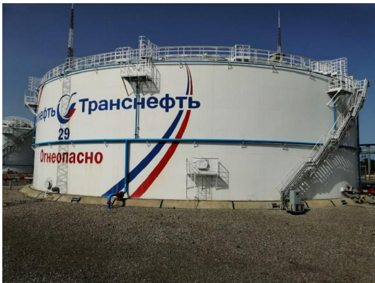
Рисунок 1 - Общий вид резервуара
