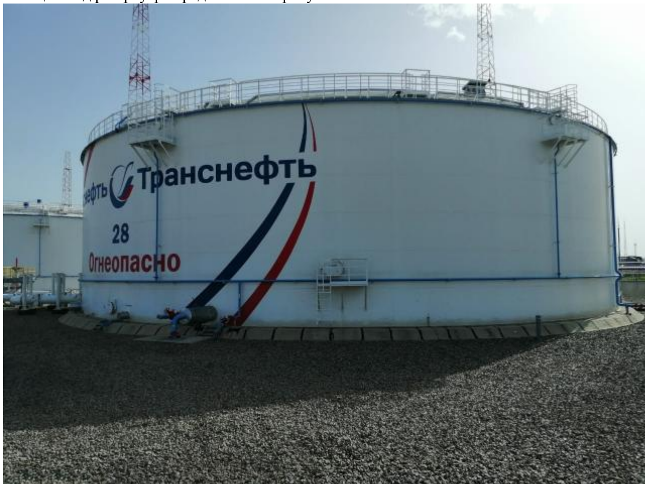
Рисунок 1 - Общий вид резервуара
