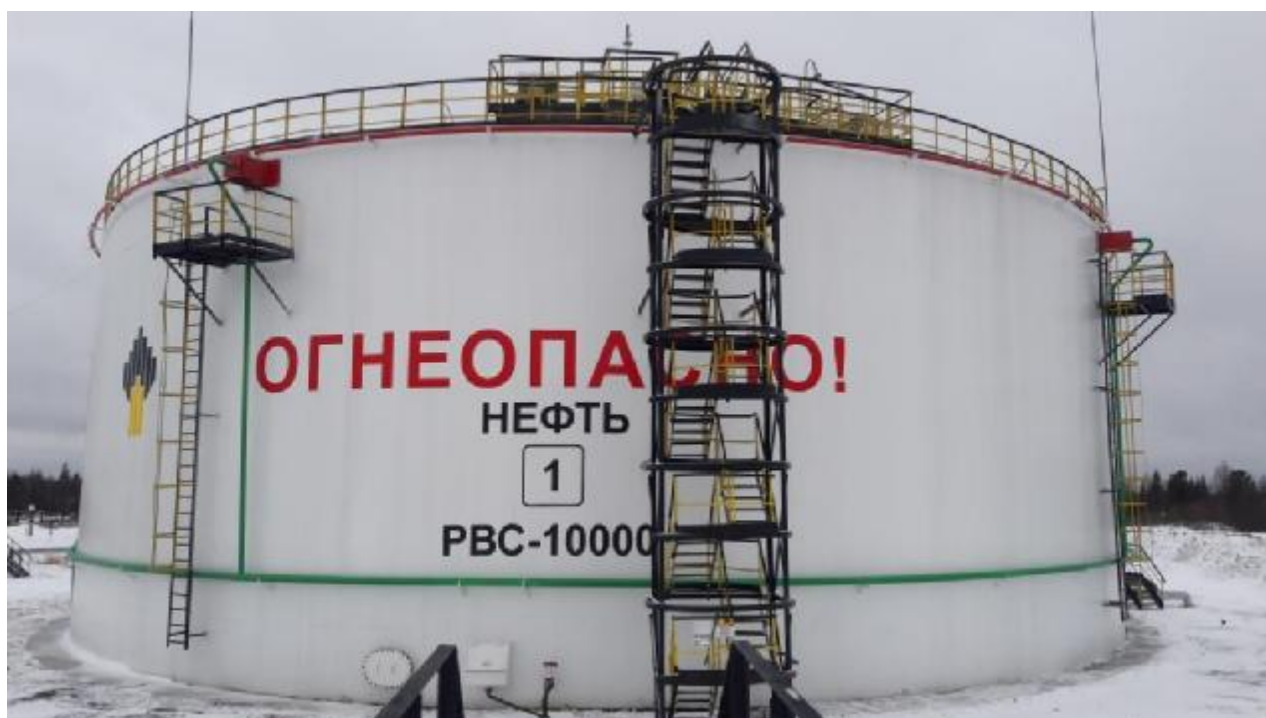
Рисунок 2 – Общий вид резервуаров стальных вертикальных цилиндрических РВС-10000
