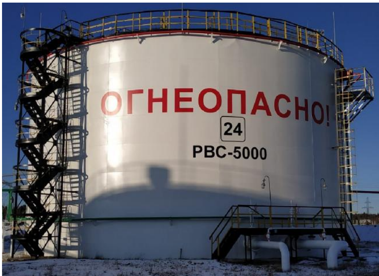
Рисунок 1 – Общий вид резервуаров стальных вертикальных цилиндрических РВС-5000
