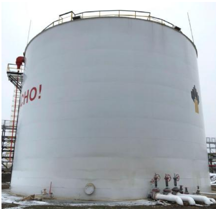
Рисунок 1 – Общий вид резервуара стального вертикального цилиндрического РВСП-5000
