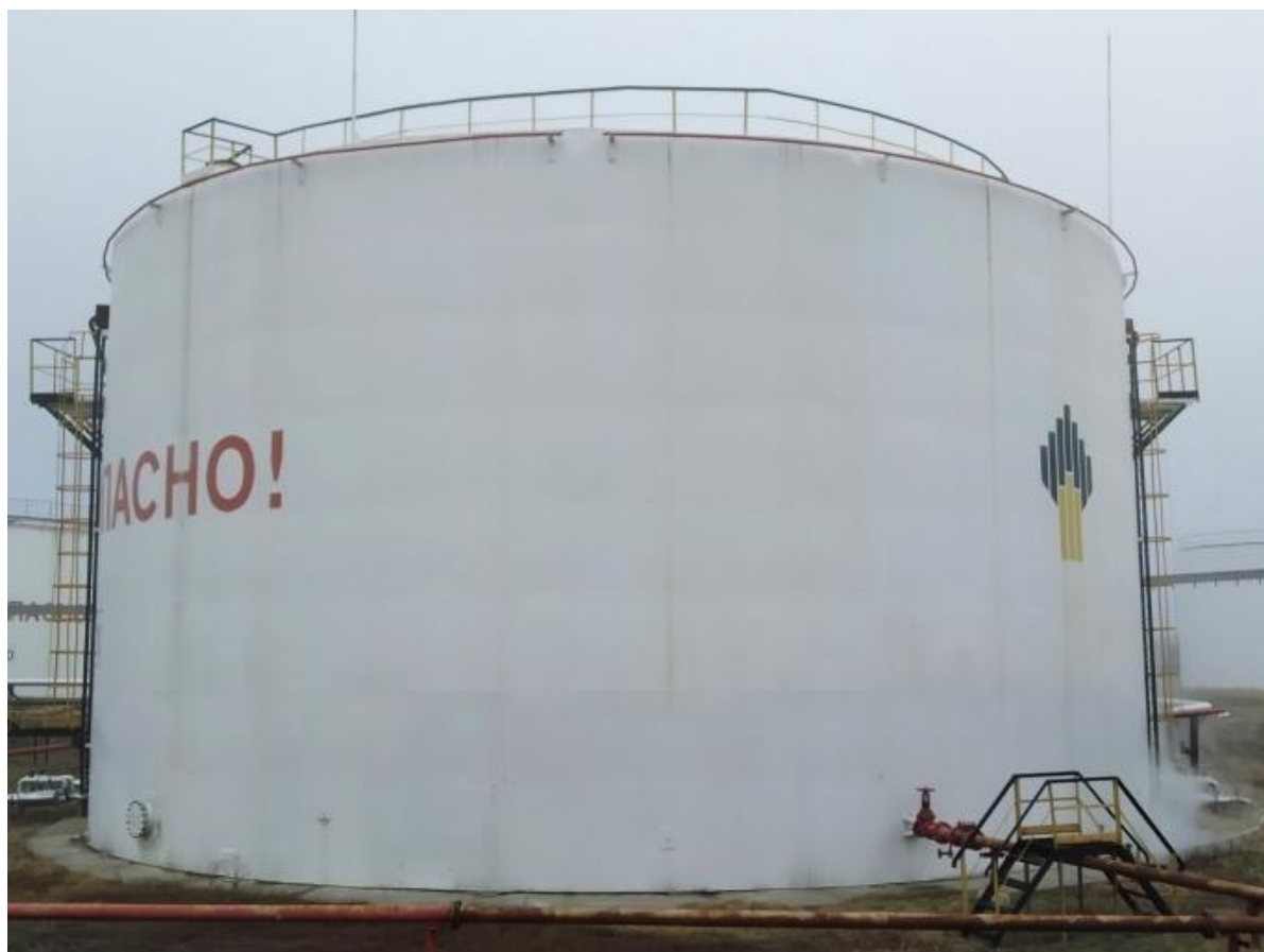
Рисунок 1 – Общий вид резервуаров стальных вертикальных цилиндрических РВС-5000
