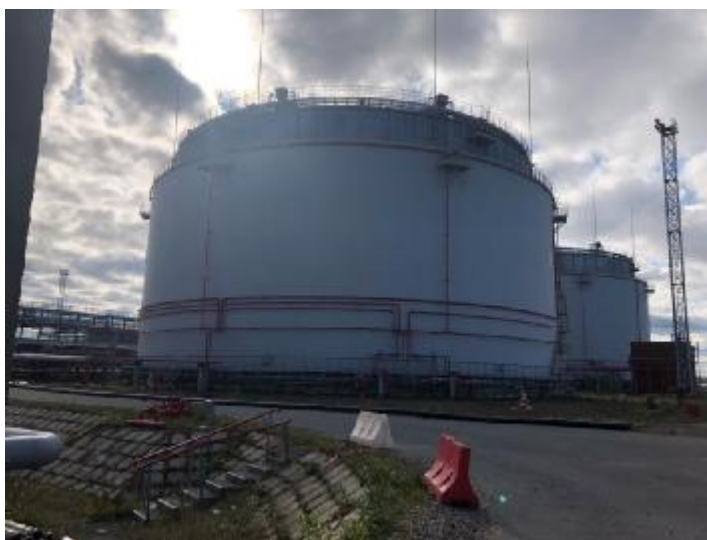
Рисунок 1 – Общий вид резервуара РВСтзс-40000
