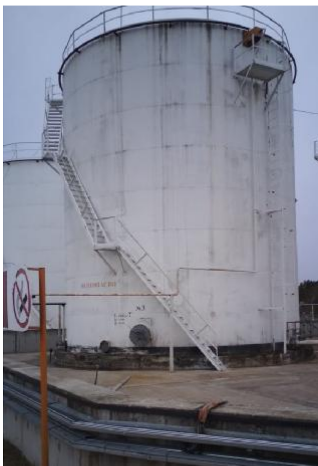
Рисунок 1 – Общий вид резервуара РВСП-1000
