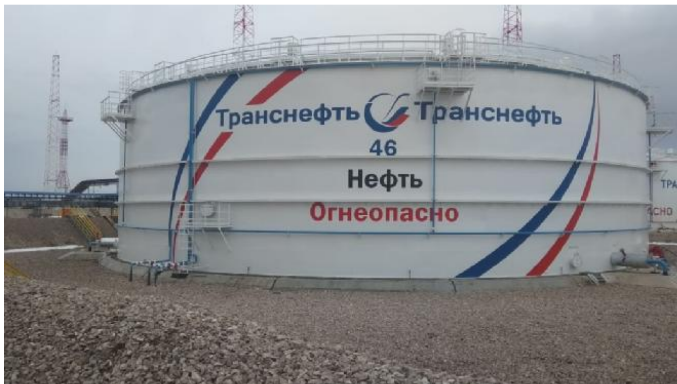
Рисунок 1 – Общий вид резервуара РВСП-20000
