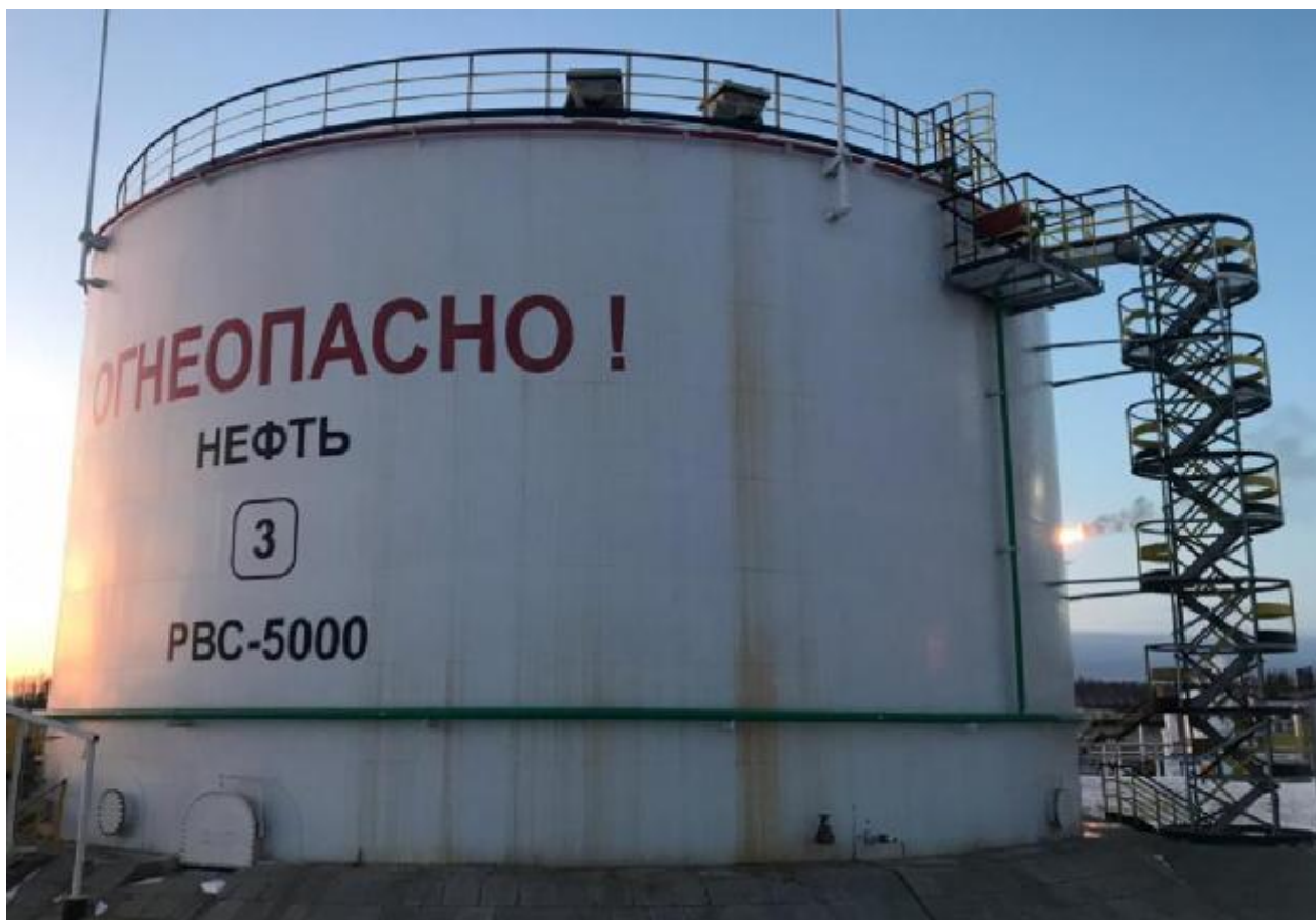
Рисунок 1 – Общий вид резервуара стального вертикального цилиндрического РВС-5000
