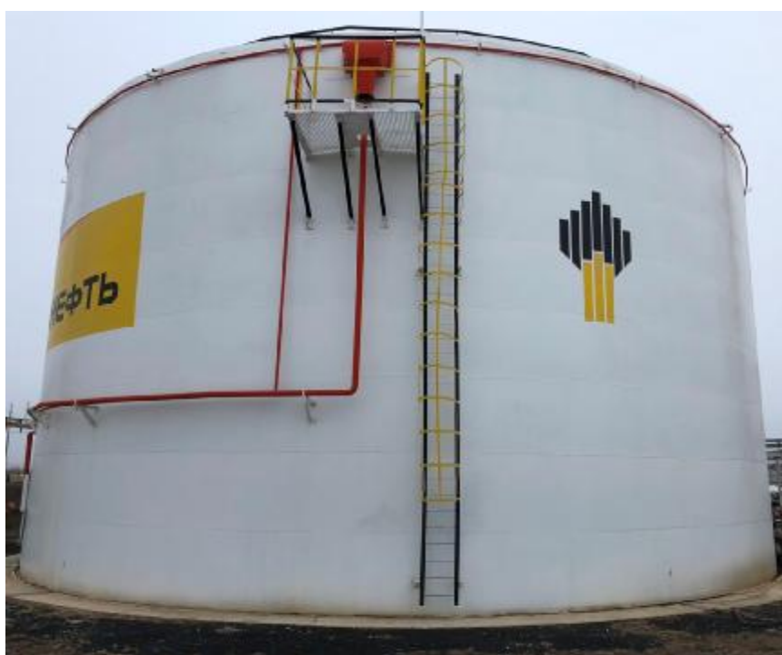
Рисунок 5 – Общий вид резервуаров стальных вертикальных цилиндрических РВС-5000
