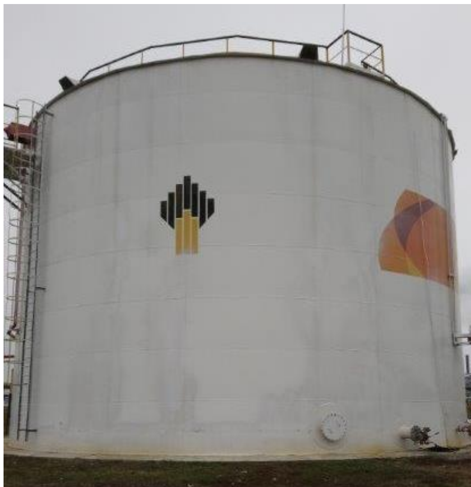
Рисунок 4 – Общий вид резервуаров стальных вертикальных цилиндрических РВСП-3000
