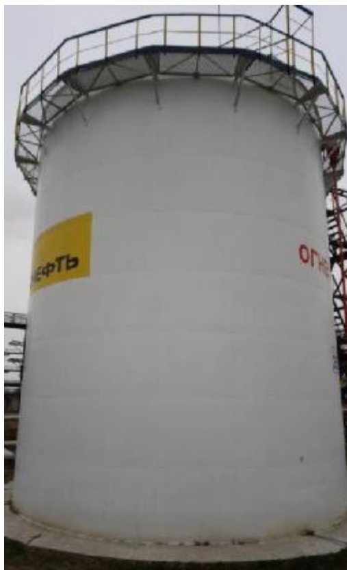
Рисунок 1 – Общий вид резервуаров стальных вертикальных цилиндрических РВС-1000
