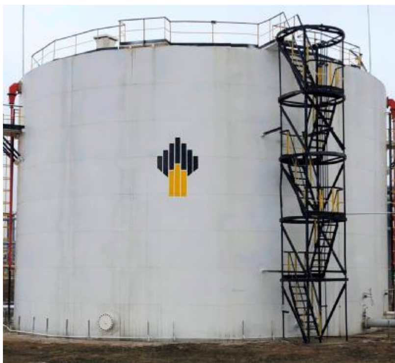
Рисунок 3 – Общий вид резервуаров стальных вертикальных цилиндрических РВС-3000
