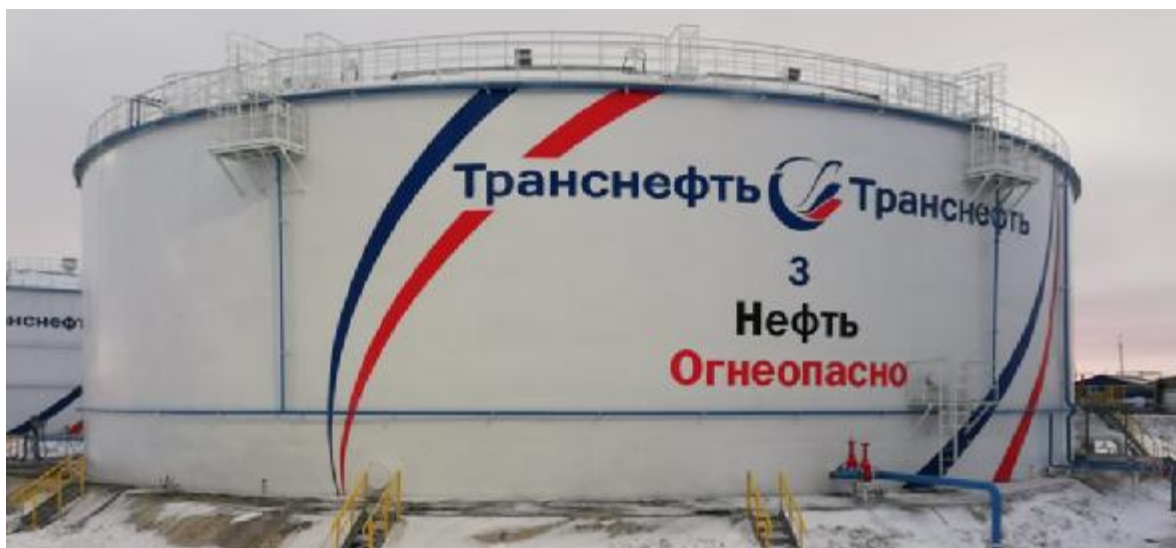
Рисунок 1 – Общий вид резервуара вертикального стального цилиндрического РВСП-20000, заводской номер 3
