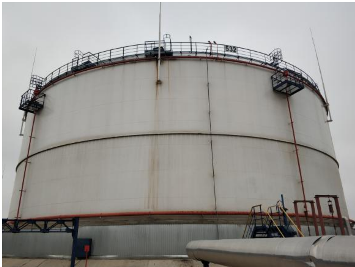
Рисунок 1 – Общий вид резервуара РВС-30000
