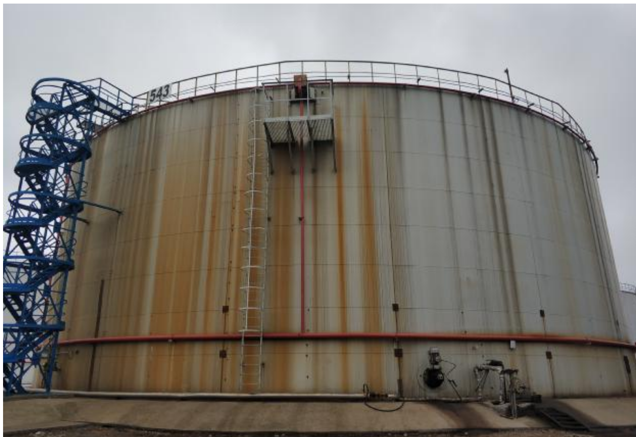
Рисунок 1 – Общий вид резервуара РВС-10000
