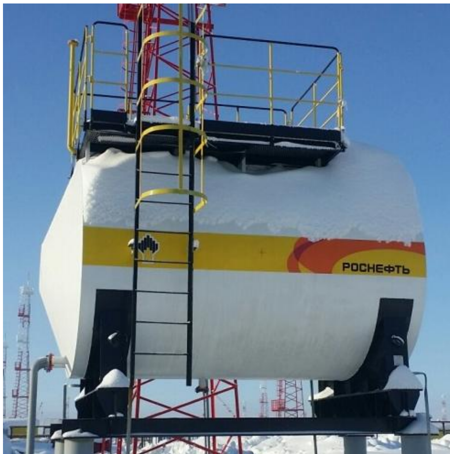
Рисунок 1 – Общий вид резервуара стального горизонтального цилиндрического РГС-25
