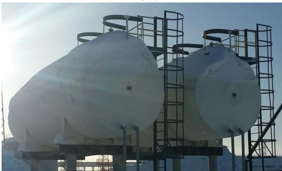
Рисунок 1 – Общий вид резервуара стального горизонтального цилиндрического РГС-25
