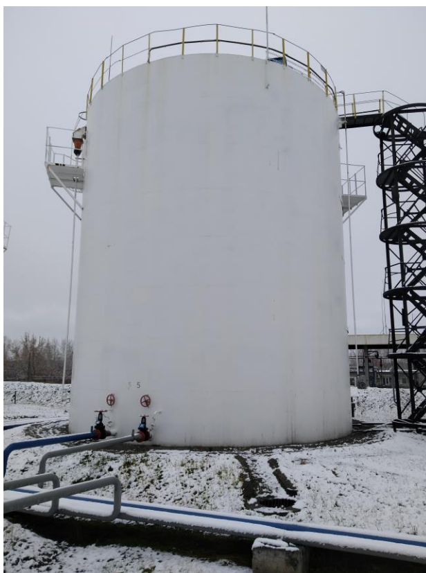
Рисунок 1 – Общий вид резервуаров стальных вертикальных цилиндрических РВС-1000
