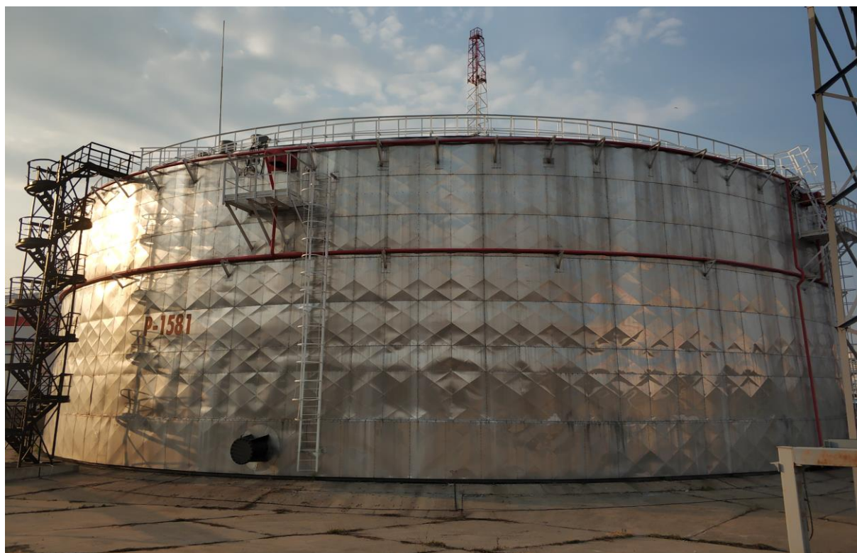
Рисунок 1 – Общий вид резервуара РВС-20000
