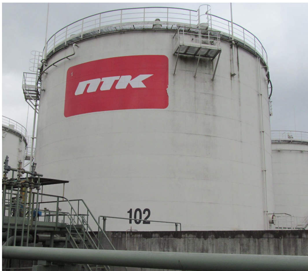
Рисунок 1 – Общий вид резервуаров стальных вертикальных цилиндрических РВСП-4900 Пломбирование резервуаров стальных вертикальных цилиндрических РВСП-4900 не предусмотрено.
