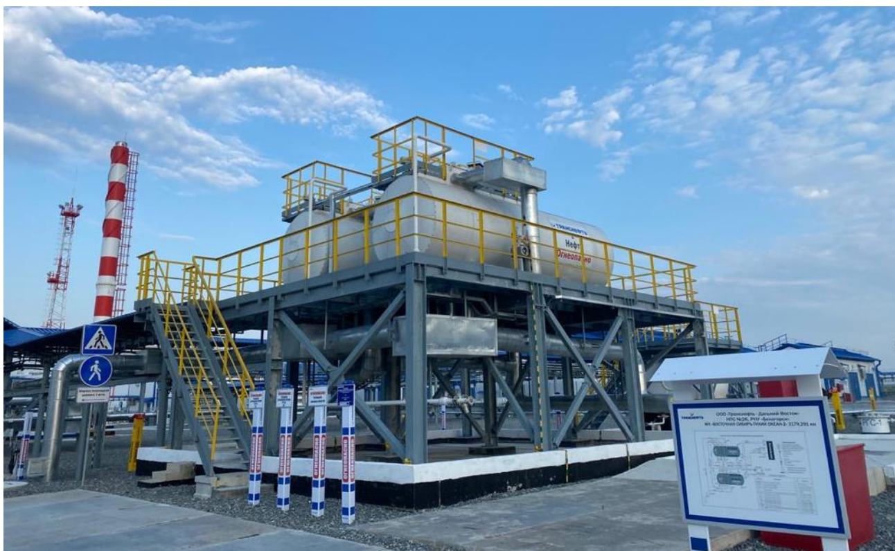
Рисунок 1 – Общий вид резервуаров РГС-20
