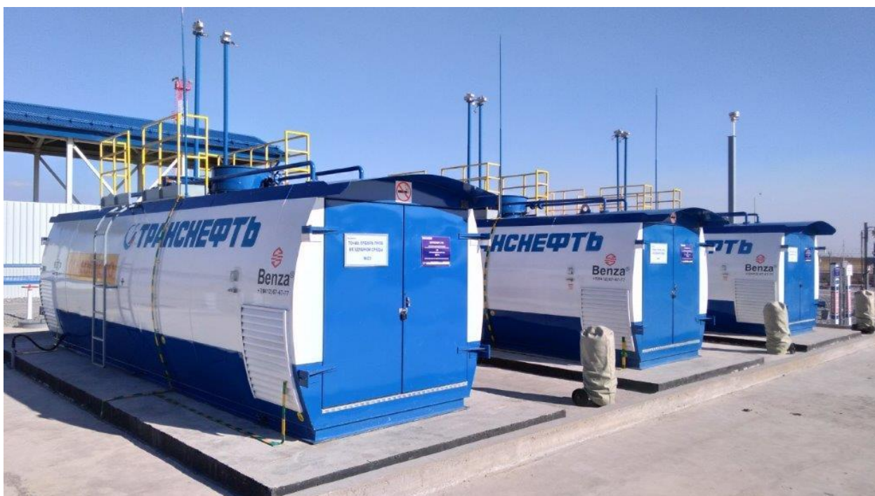
Рисунок 2 – Общий вид резервуаров РГС-20
