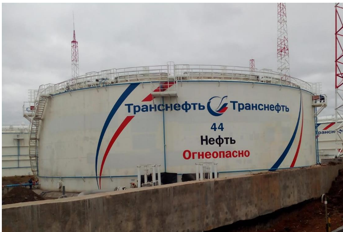
Рисунок 1 – Общий вид резервуара РВСП-20000
