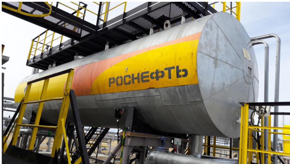
Рисунок 3 – Общий вид резервуара стального горизонтального цилиндрического РГС-25
