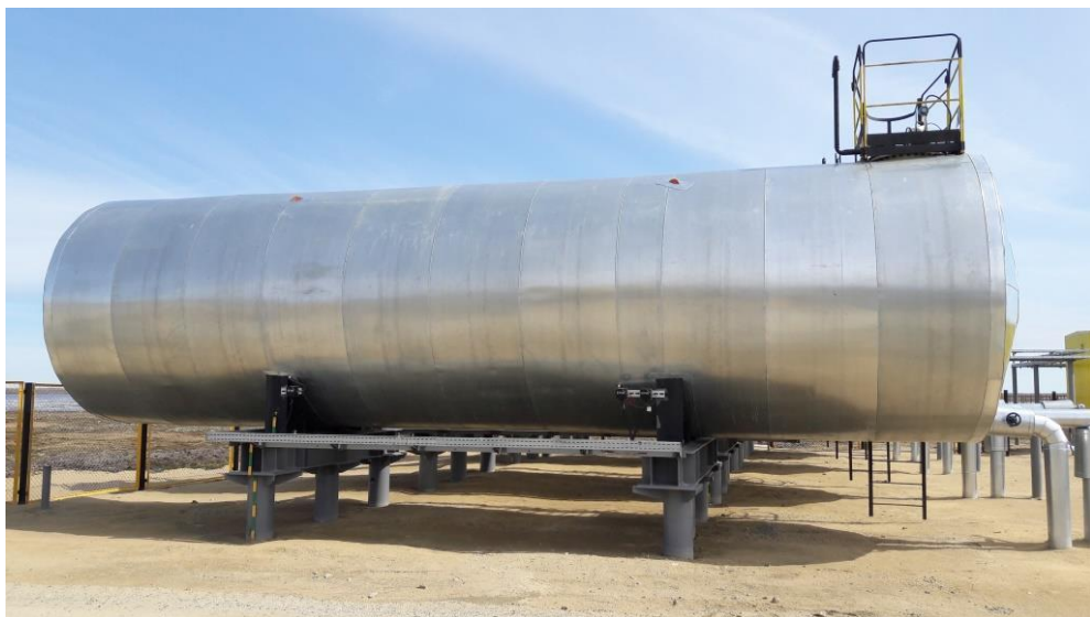
Рисунок 4 – Общий вид резервуара стального горизонтального цилиндрического РГС-100
