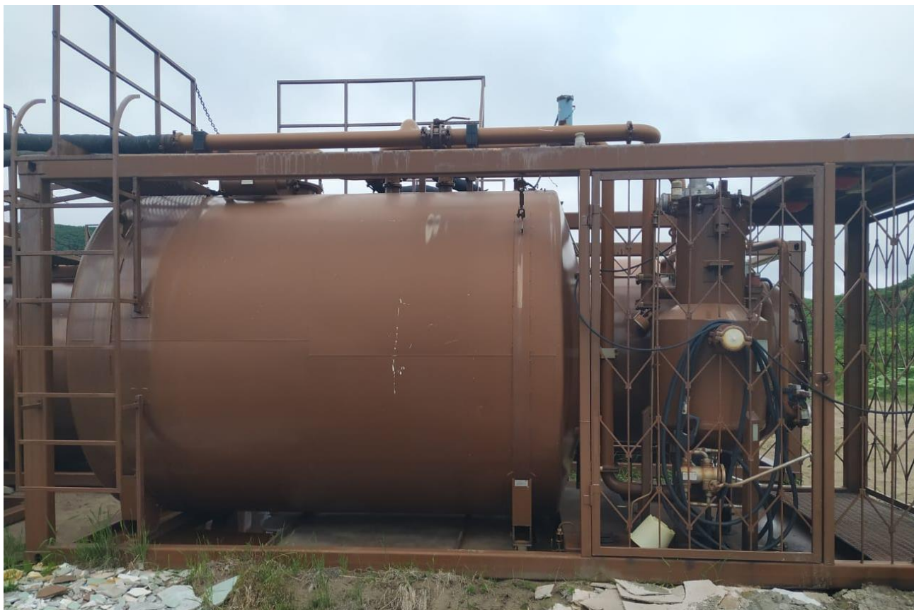
Рисунок 1 – Общий вид резервуаров Рк-15
