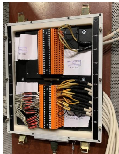
Рисунок 4 – Схема пломбировки от несанкционированного доступа МІС-140/96
