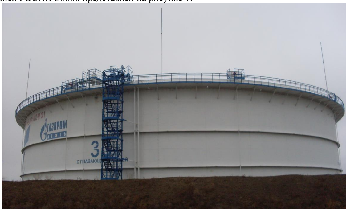
Рисунок 1 – Общий вид резервуаров стальных вертикальных цилиндрических с плавающей крышей РВСПК-50000
