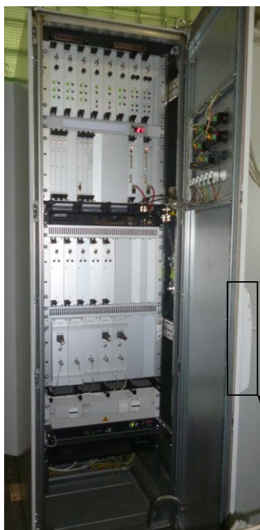
Рисунок 2 – Общий вид приборного шкафа, в котором расположены компоненты ИК
