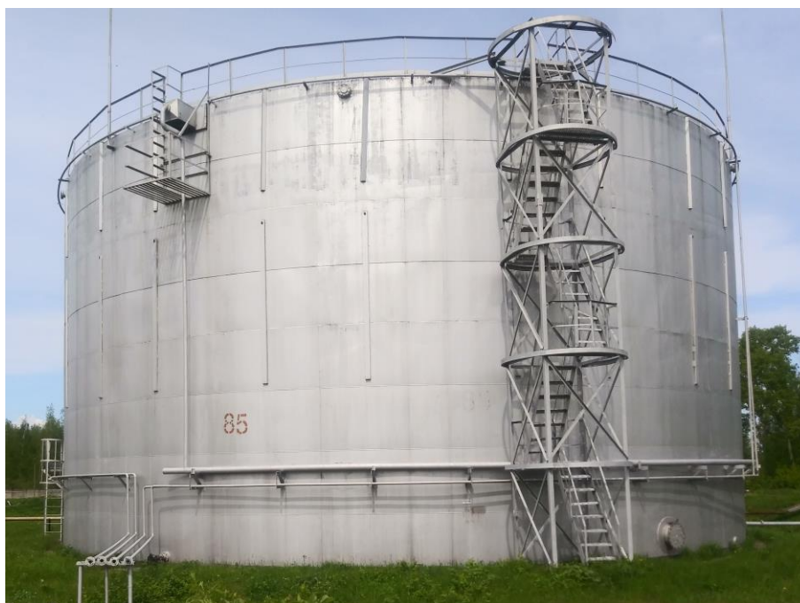
Рисунок 1 - Общий вид резервуаров вертикальных стальных цилиндрических РВС-5000, состоящих из 8 поясов
