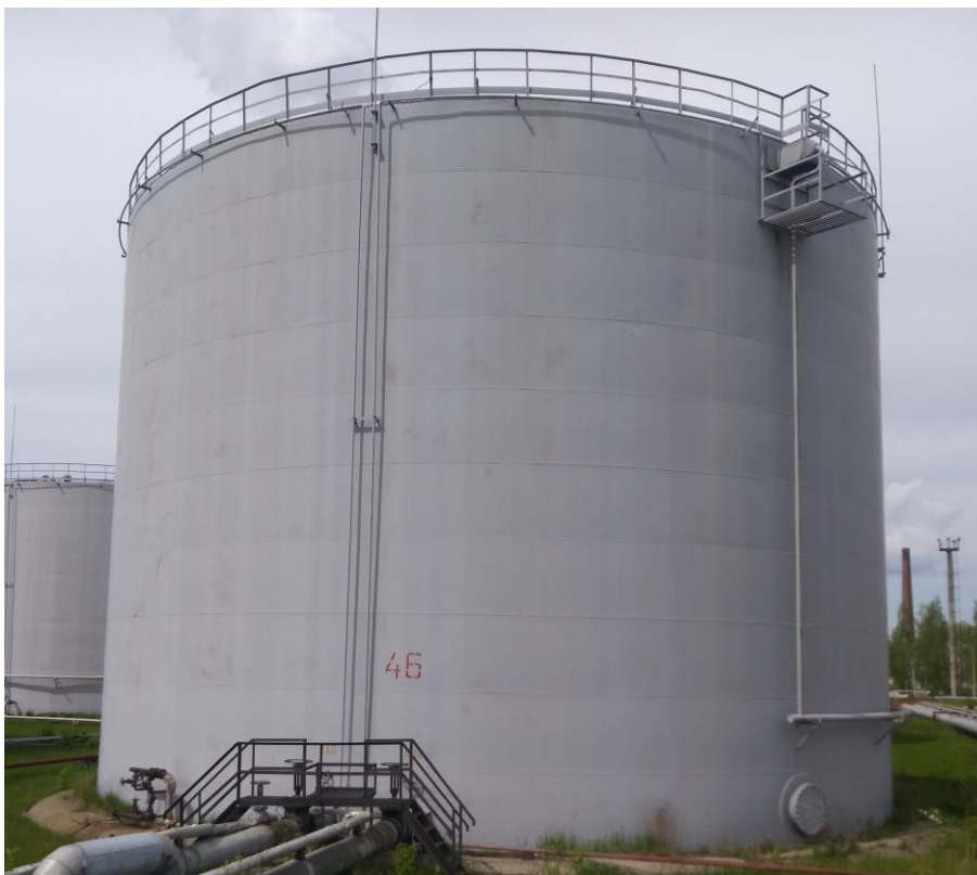
Рисунок 2 - Общий вид резервуара вертикального стального цилиндрического РВС-5000, состоящего из 10 поясов
