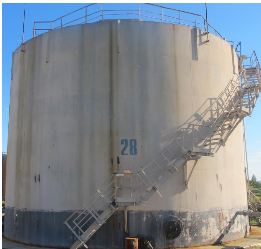
Рисунок 1 – Общий вид резервуара стального вертикального цилиндрического РВС-1000
