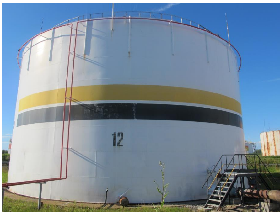
Рисунок 1 – Общий вид резервуара стального вертикального цилиндрического РВС-5000
