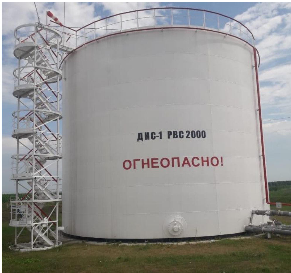
Рисунок 1 – Общий вид резервуара РВС-2000
