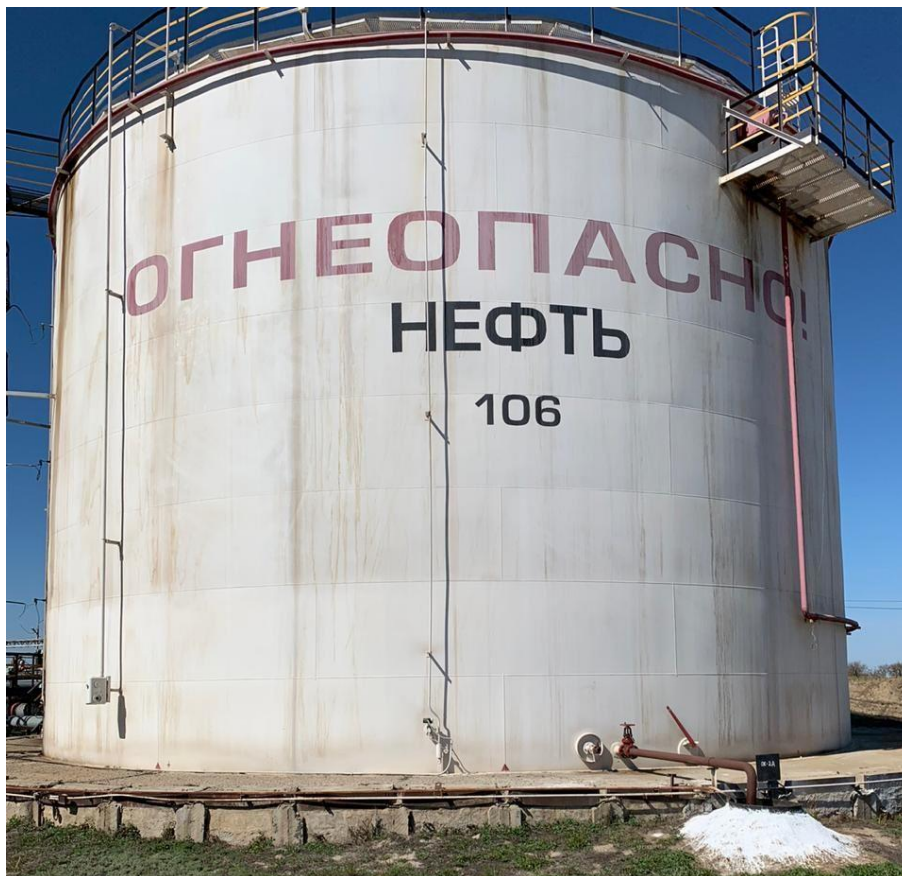
Рисунок 1 – Общий вид резервуара стального вертикального цилиндрического РВС-3000
