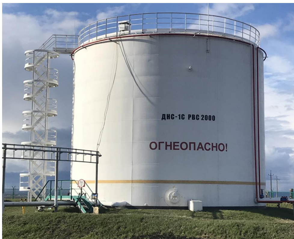
Рисунок 1 – Общий вид резервуара РВС-2000
