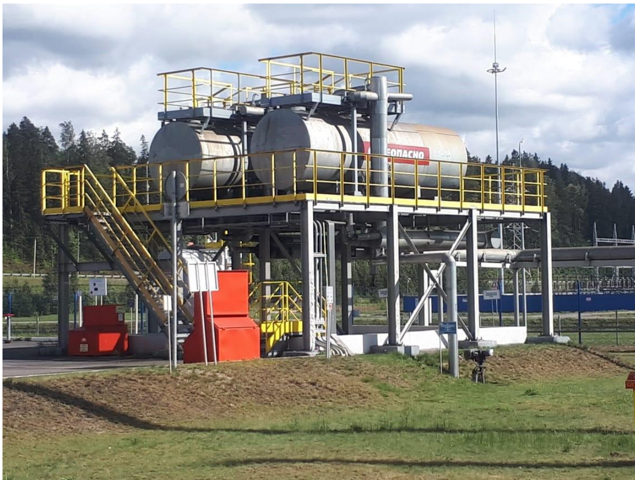
Рисунок 1 – Общий вид резервуаров горизонтальных стальных цилиндрических РЦ-20
