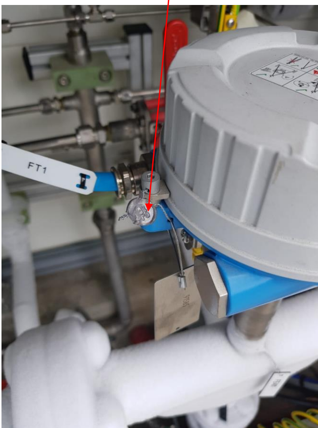
Рисунок 2 – Места нанесения пломбы знака поверки на: преобразователи расхода массовые LNGmass, электронно-вычислительные устройства Cryostar Cryofueltronics, маркировочную табличку.
