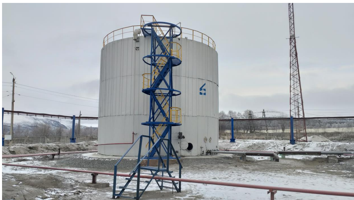
Рисунок 2 – Общий вид резервуара РВС-700
