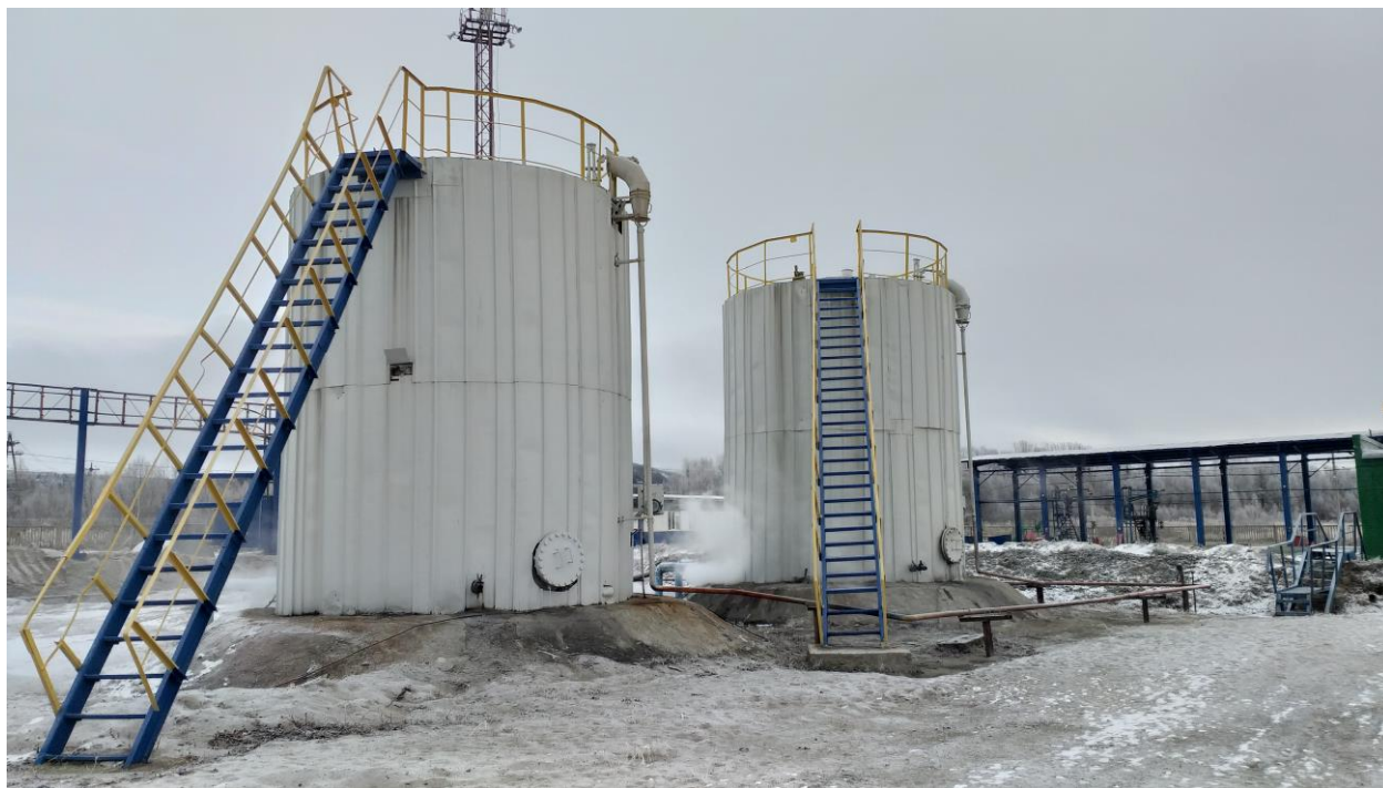
Рисунок 1 – Общий вид резервуаров РВС-100
