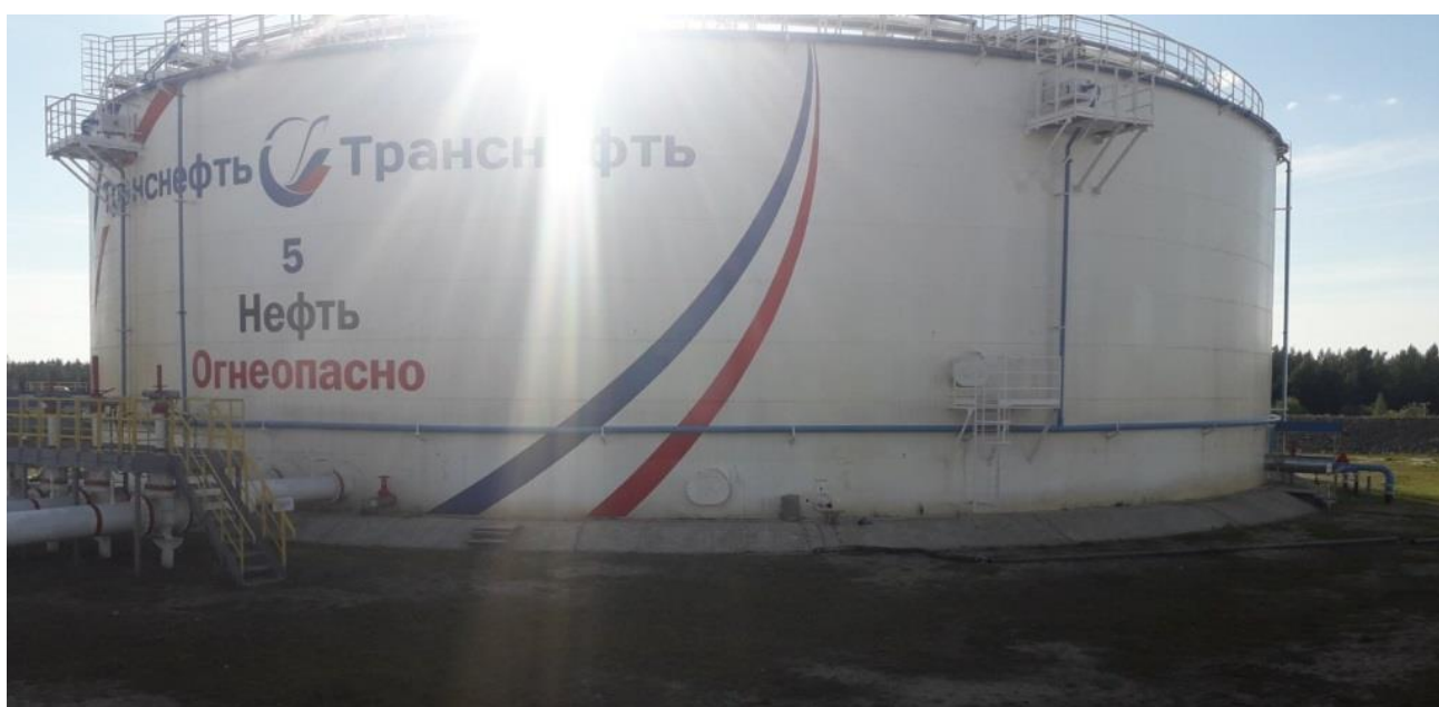
Рисунок 2 – Общий вид резервуаров РВСП-20000
