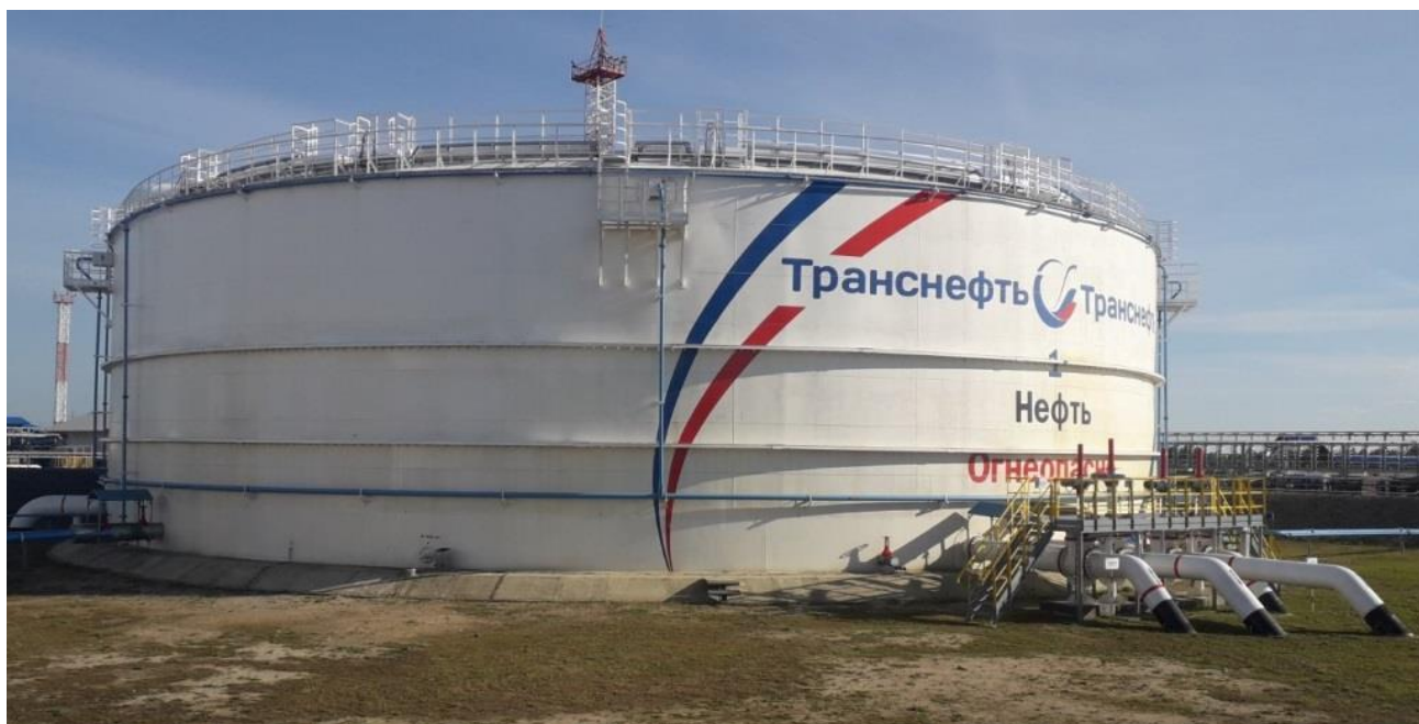
Рисунок 1 – Общий вид резервуара РВС-20000
