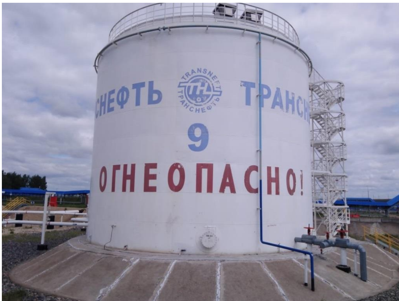
Рисунок 1 – Общий вид резервуара РВС-2000
