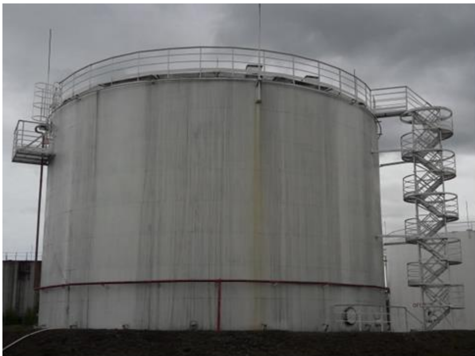
Рисунок 1 – Общий вид резервуаров стальных вертикальных цилиндрических РВС-3000
