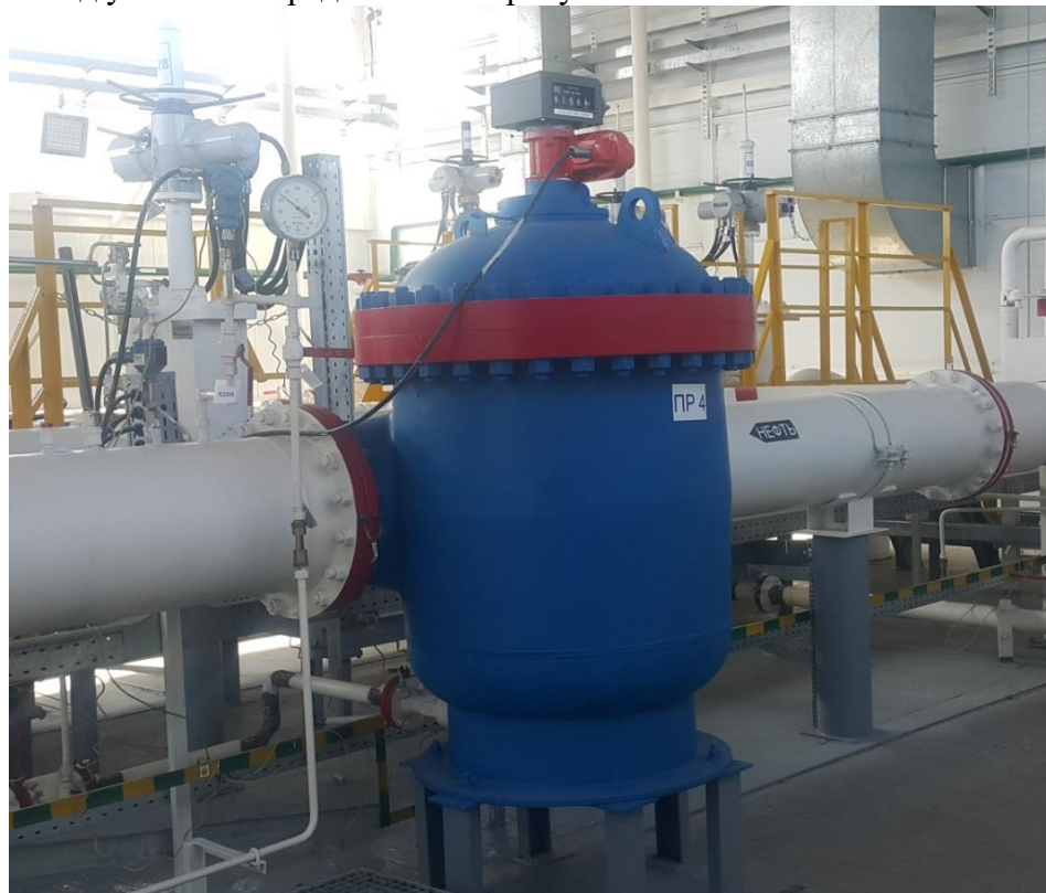
Рисунок 1 – Общий вид установки поверочной на базе лопастного счетчика
