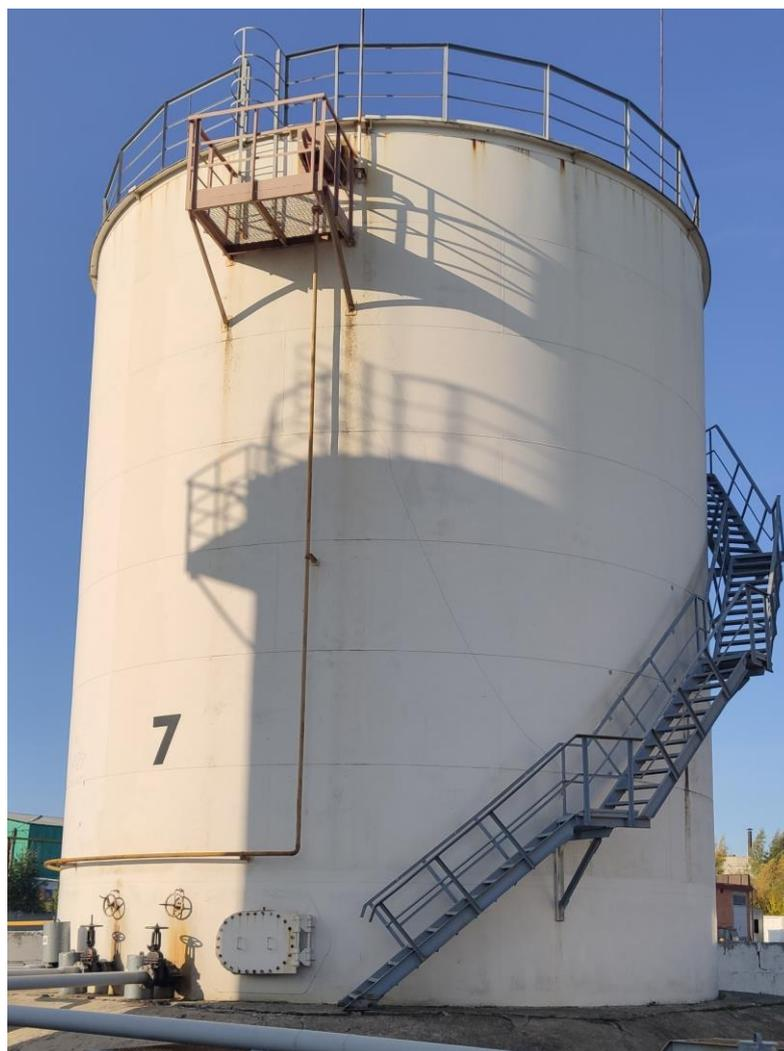
Рисунок 1 – Общий вид резервуара РВС-1000
