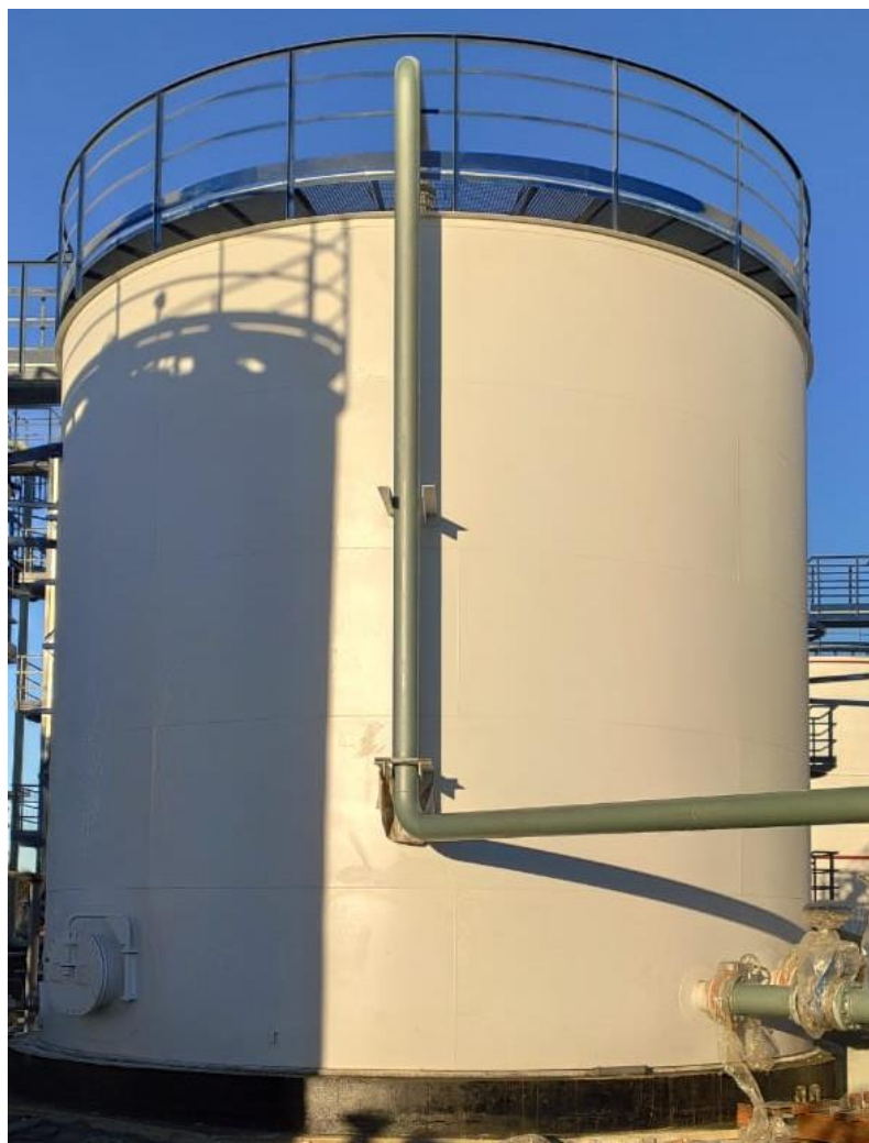
Рисунок 1 – Общий вид резервуаров РВС-400
