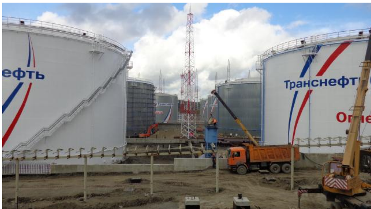
Рисунок 1- Общий вид резервуаров № 5, 6
