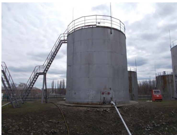
Рисунок 1 – Общий вид резервуаров стальных вертикальных цилиндрических РВС-400
