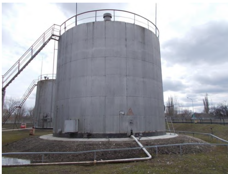
Рисунок 1 – Общий вид резервуаров стальных вертикальных цилиндрических РВС-700
