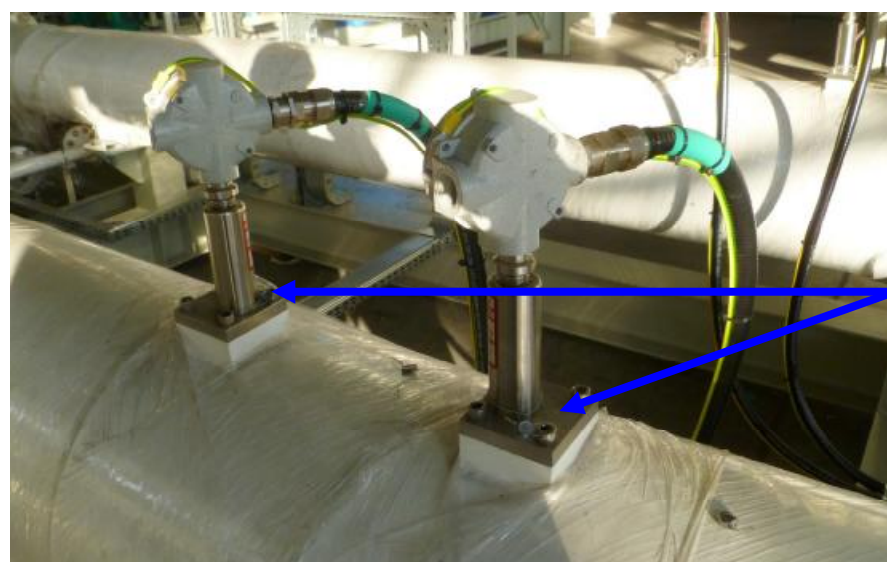
Рисунок 4 - Места пломбирования ТПУ OGSB
