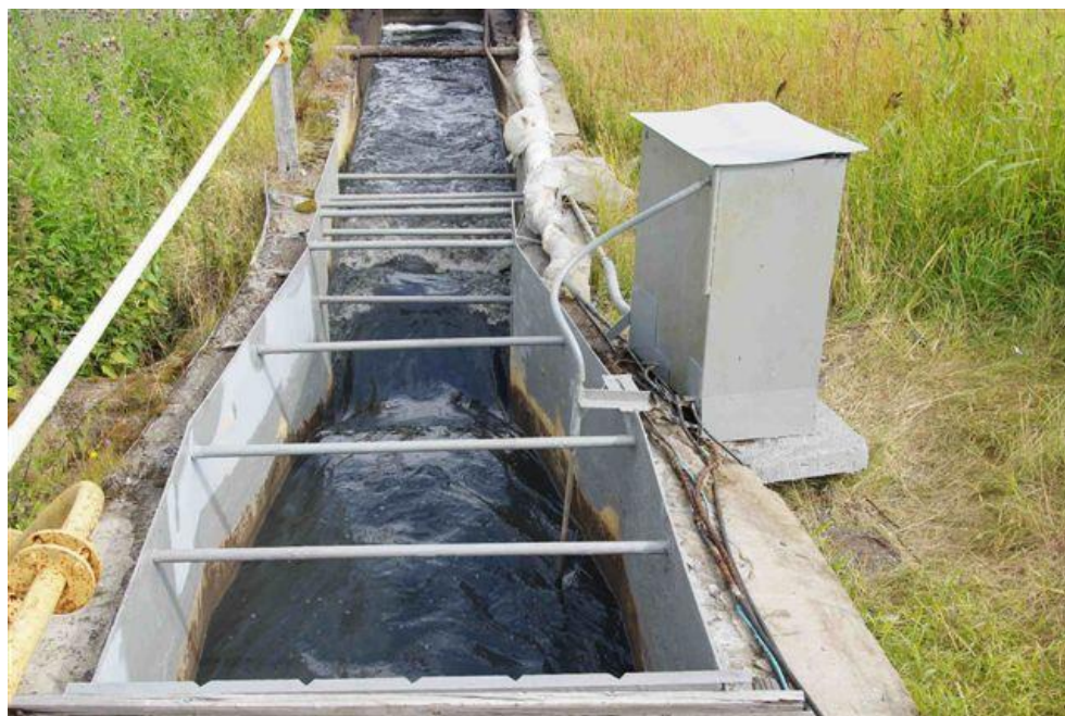
Рисунок 1 – Общий вид системы измерений расхода и количества хозяйственно-бытовых стоков на основе лотка Паршалла
