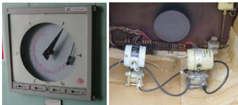
Рисунок 2 – Общий вид системы измерений расхода и количества хозяйственно-бытовых стоков на основе лотка Паршалла
