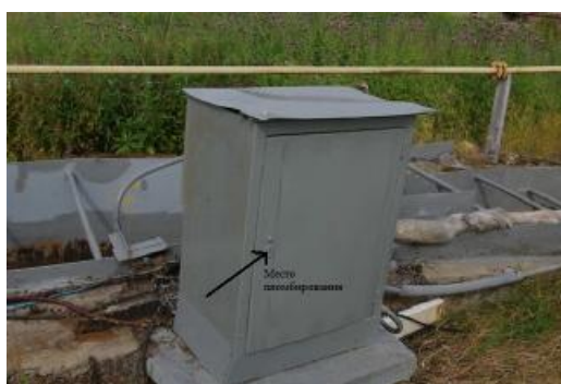
Рисунок 3 – Схема пломбирования системы измерений расхода и количества хозяйственно-бытовых стоков на основе лотка Паршалла
