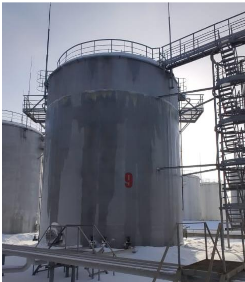
Рисунок 1 – Общий вид резервуаров РВС-1000
