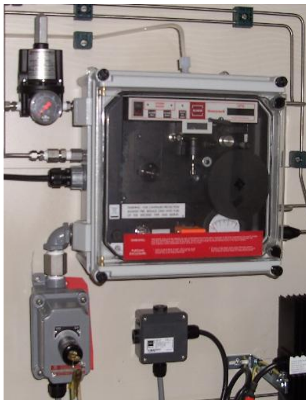
Рисунок 2 – Внешний вид газоанализаторов с системой продувки Z-purge
