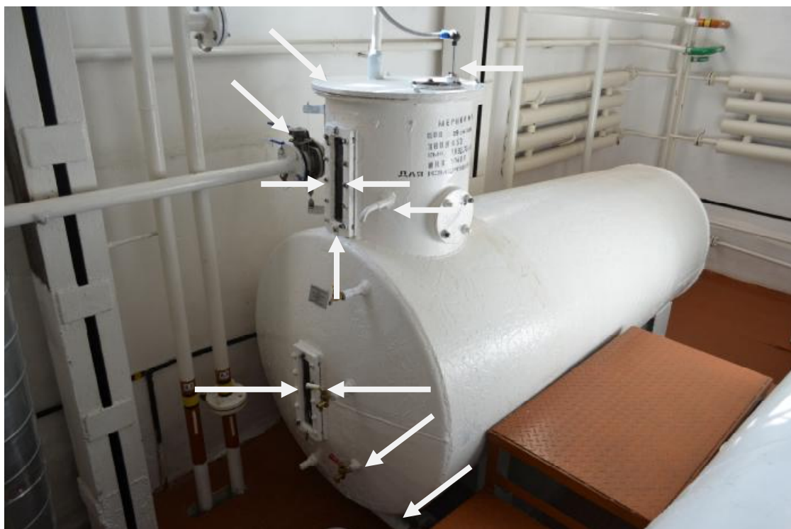
Рисунок 1 - Общий вид и места пломбирования мерника
